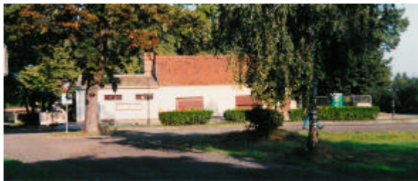
Der alte Konsum vor dem Umbau Foto: Manuela Vollbrecht
